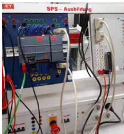
SPS-Ausbildung auf Top-Niveau: die von Schülern in der ET-Werkstätte verbaute Siemens Simatic S7-1200.
