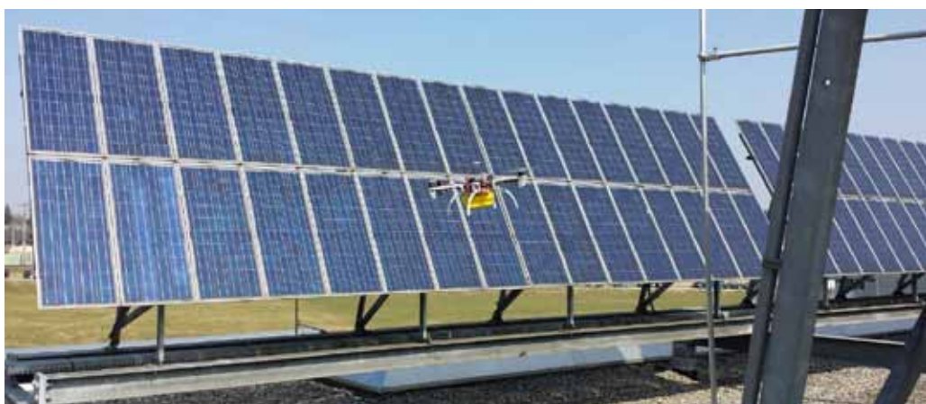
Durchführung der Überprüfung an der Anlage der HTL St. Pölten
