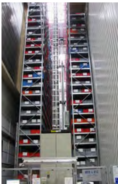
Geberit: Produktion und Kleinteilelager
